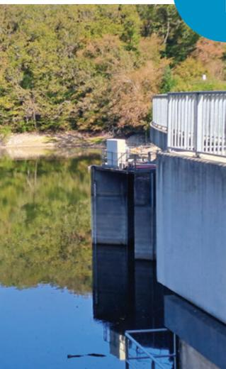
L'eau brute est captée en amont du barrage. Les plus gros éléments (poissons, branches, feuilles, etc.) sont stoppés par une grille puis l'eau est acheminée vers l'usine.
